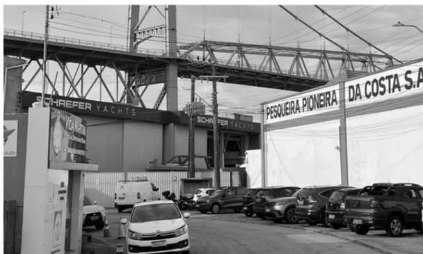
6. Ponte / Estaleiro / Pesqueira Pioneira da Costa
