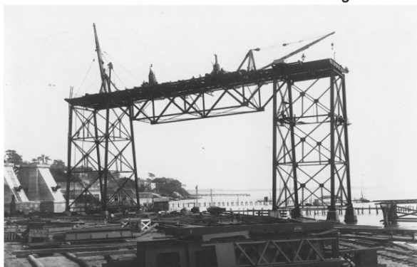
5. Canteiro de Obras da Ponte no Continente
