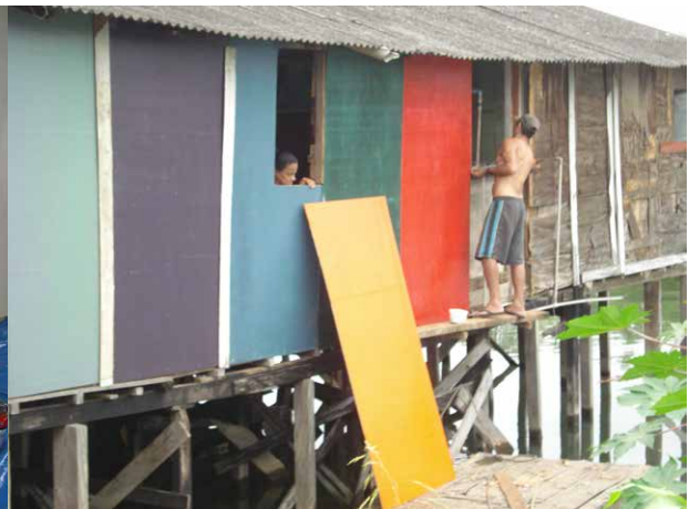
Foto 10. Sistema de troca dos madeirites. Cores no Dique, 2009 - 2013.
