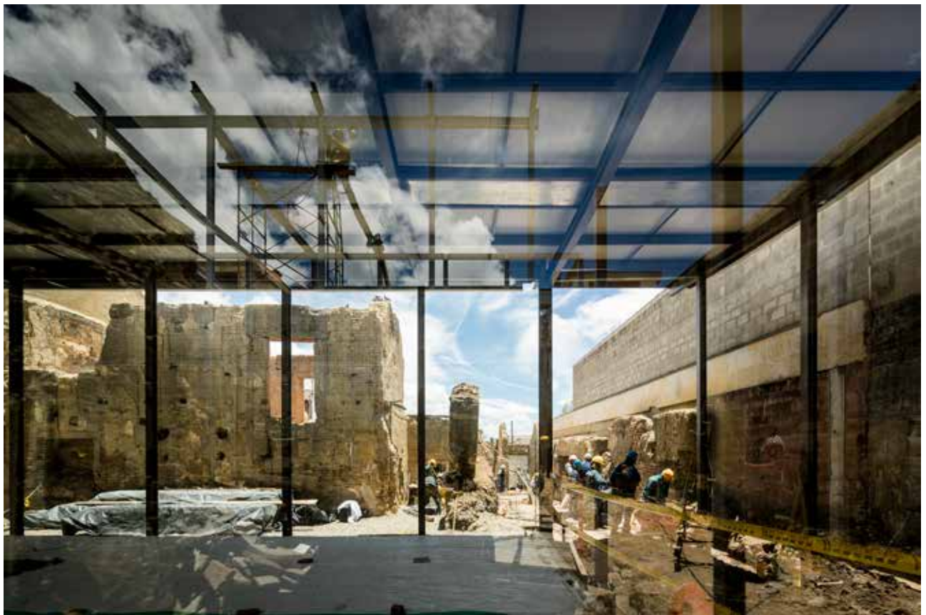
Figure 3 Construction of Fragmentos. Espacio de Arte y Memoria , Bogotá, Colombia. Photograph of Juan Fernando Castro. Courtesy of Fragmentos, Espacio de Arte y Memoria of the Ministry of Culture of Colombia.
